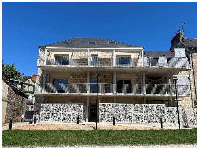
Après travaux à l'arrière © Noalis
