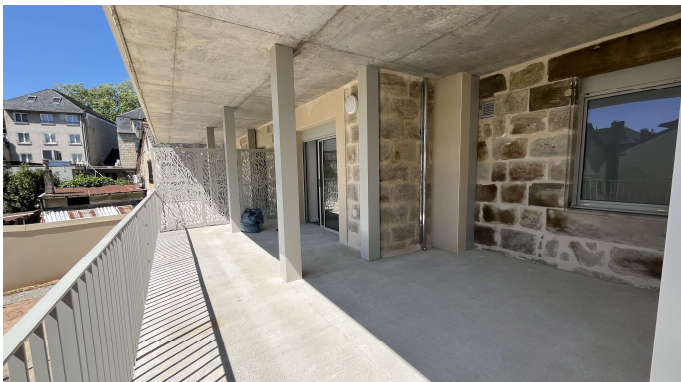
Terrasse après travaux © Noalis
