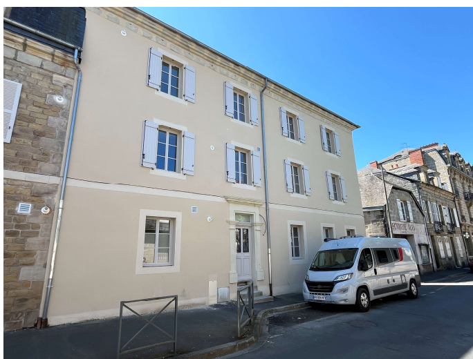
Après travaux © Noalis
