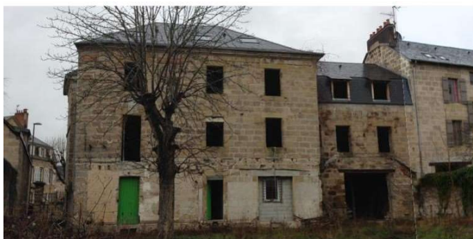
Avant travaux à l'arrière côté jardin © Noalis
