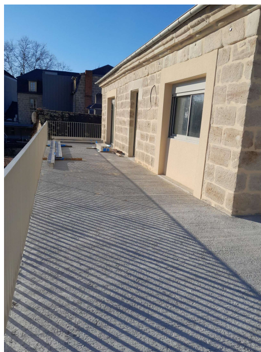
Terrasse après travaux © Noalis
