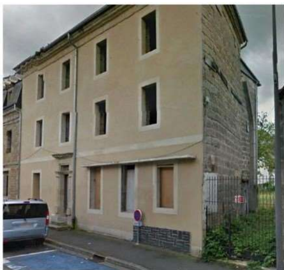
Avant travaux côté rue © Noalis
