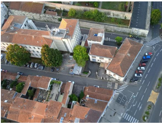
Vue aérienne du bâtiment © Noalis
