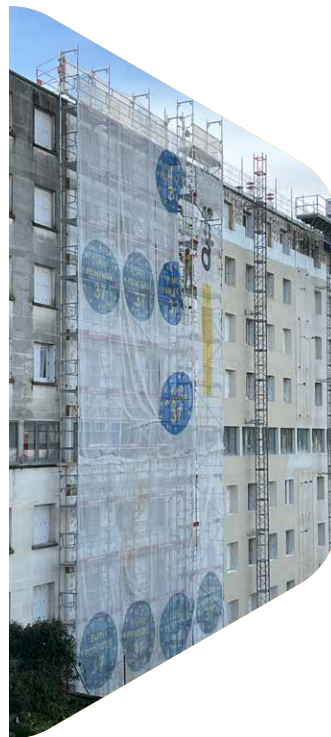
Visite de chantier de la réhabilitation de la résidence Renoleau à ANGOULÊME (16) Rénovation de 75 logements en site occupé
